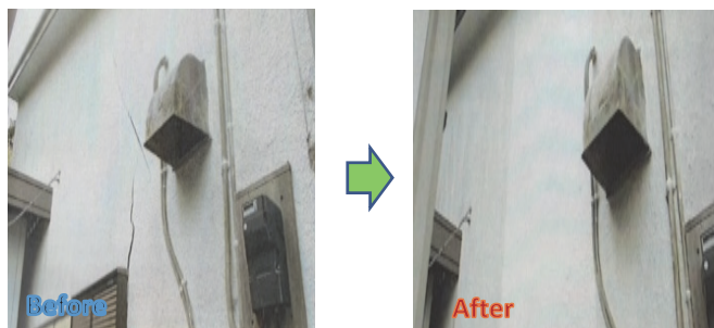
外壁ひびの補修
