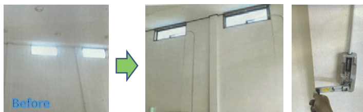
排煙窓の改修
